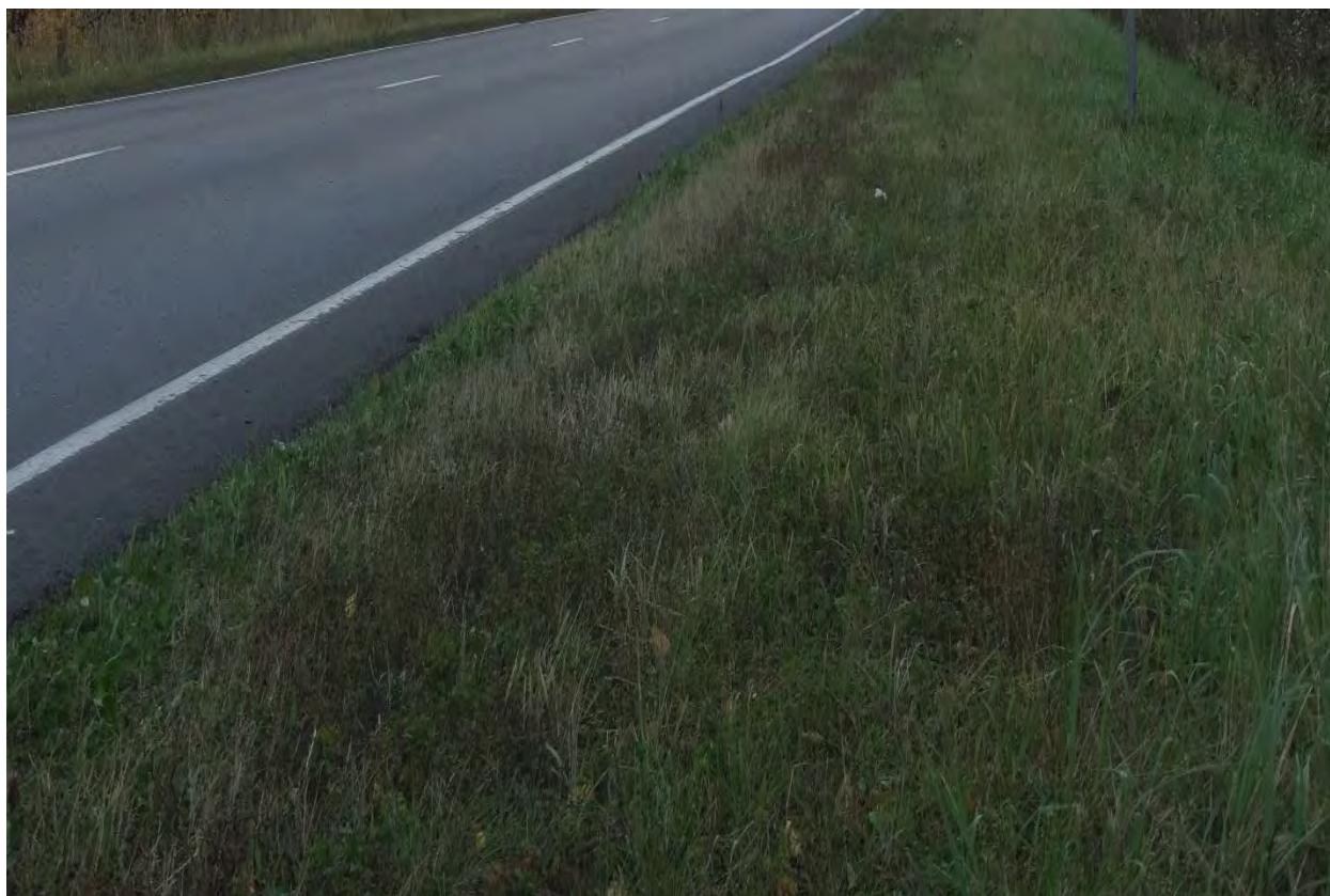
Рис.9. Состояние укрепления обочин на автомобильной дороге А-143 «Шацк-Тамбов»
