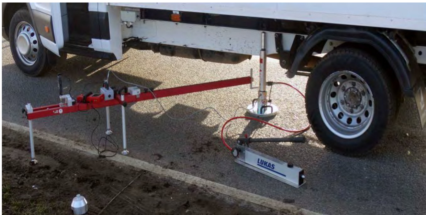
Рис. 9. Проведение штамповых испытаний
