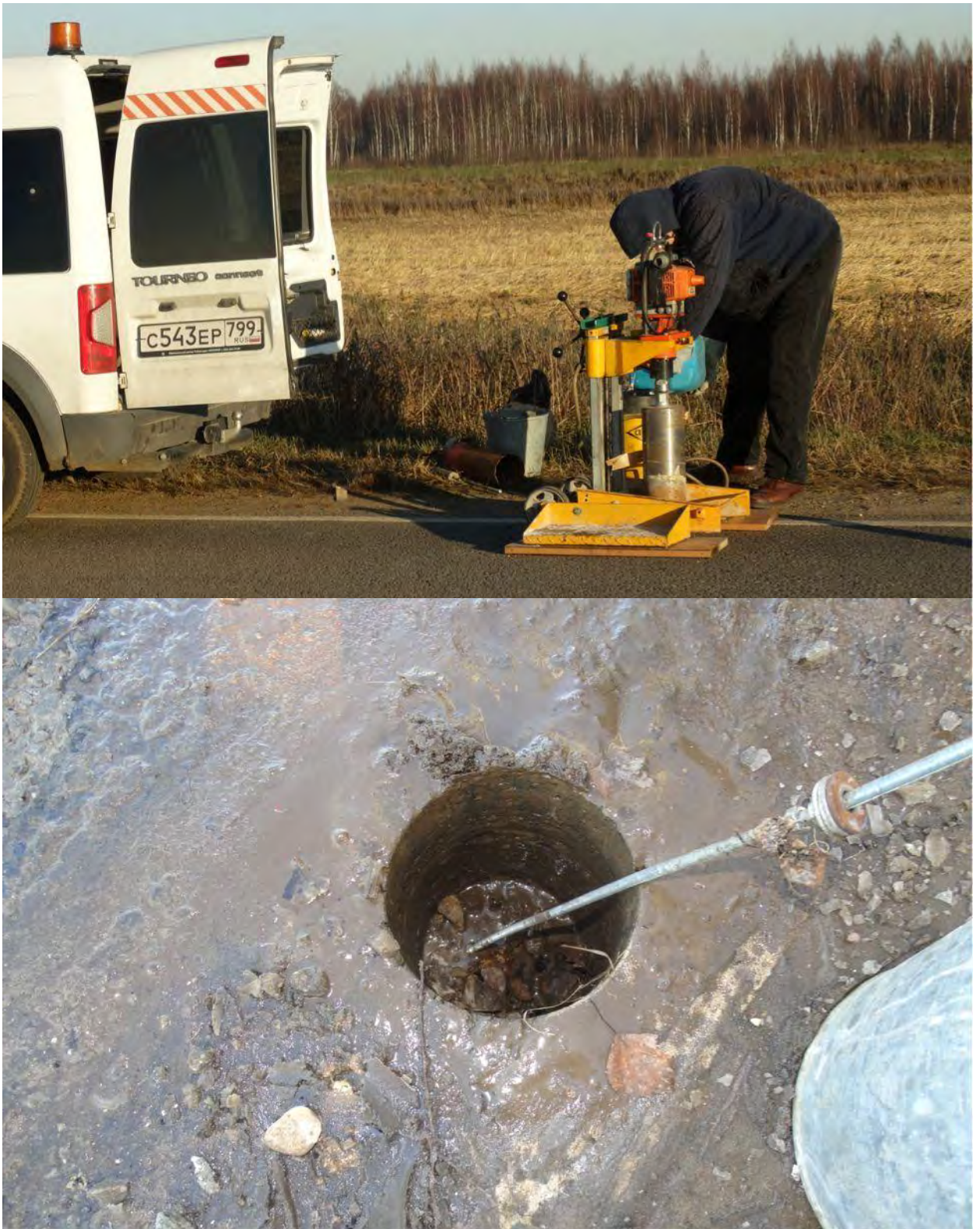
Рис. 6. Проведение буровых работ.
