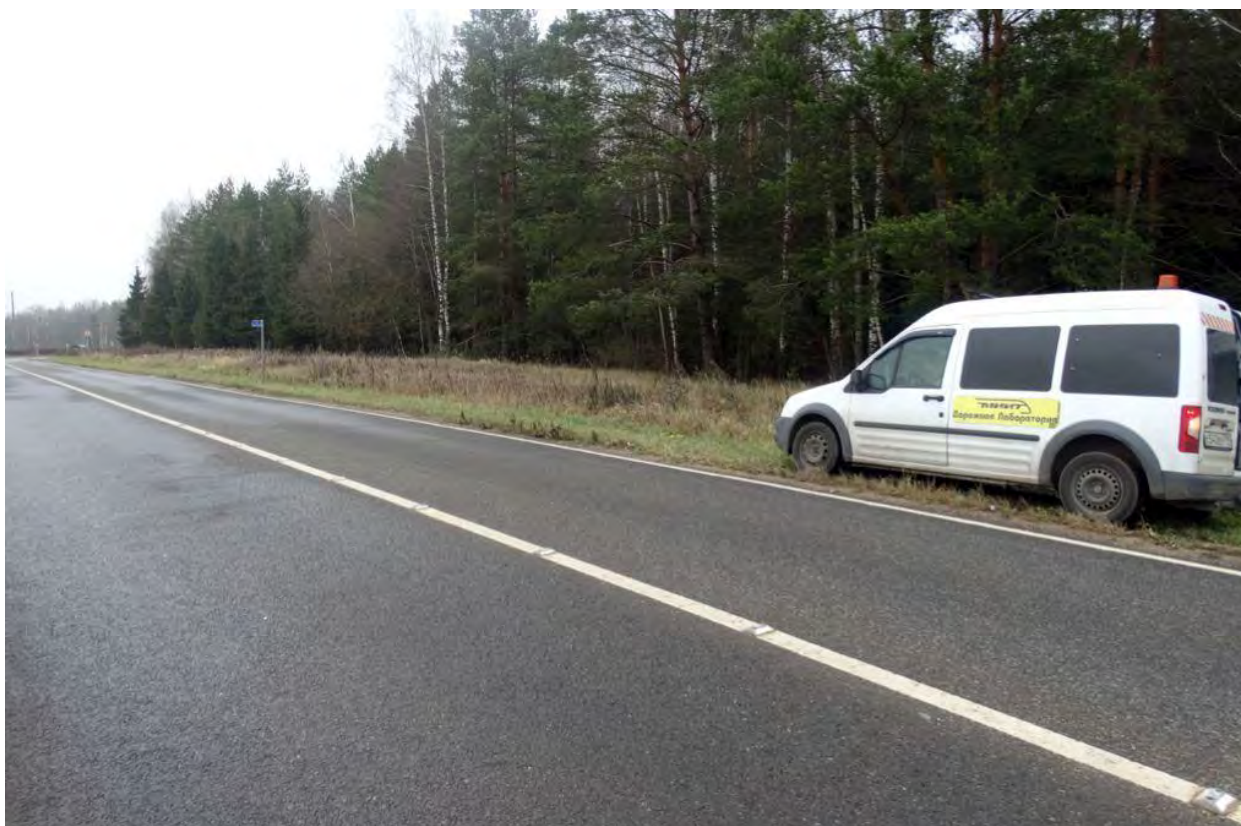
Рис.2. Участок обследуемой автодороги
